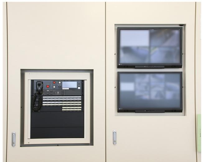
中学校には小学校に設置されている非常・業務用放送設備の非常用リモコンと、防犯カメラ映像を確認するモニター2台が設置されている。小学校と同様に小学校・中学校の両方に放送ことができ、防犯カメラの映像も確認できるようになっている。
