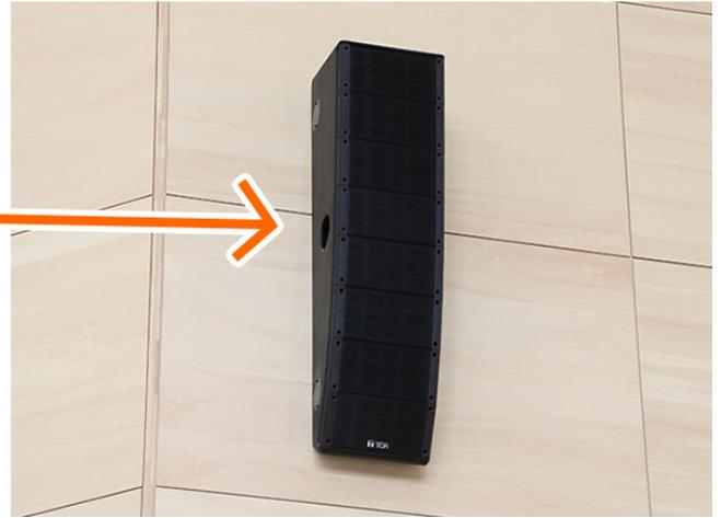
一般的な体育館より天井の高い中学校の体育館。反響の大きい環境下でも明瞭性が高く臨場感のある音空間を実現。前方にはメインスピーカーとして指向性が高いラインアレイスピーカーSR-T5を2台設置。
