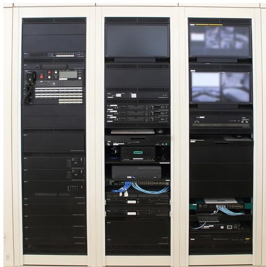
小学校に設置されている非常・業務用ラック型放送設備FS-2500シリーズと防犯カメラシステムのITV架。火災等の非常時には、小学校・中学校の両方に放送することができる。モニターでは、学校全体を死角なく確認することができる。
