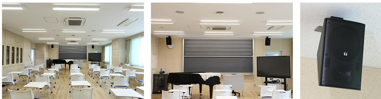
中学校校舎棟3階にある音楽室。教室前方にはメインスピーカーとしてコンパクトスピーカーF-2000Bが2台、サブスピーカーとして教室中央に広指向性天井埋込型スピーカーが4台設置され、デジタルステレオミキサーの自動音場補正機能や自動ハウリング抑制機能などにより、明瞭性が高く、快適な音空間を構築している。
