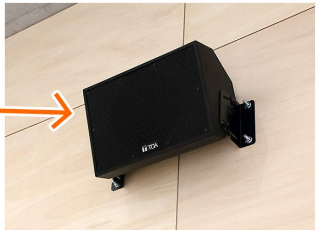
体育館後方には2台のサブスピーカーを設置。デジタルスピーカープロセッサのデジタル信号処理で音量の補正と均一な音空間を構築している。
