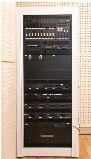
中学校体育館のステージ横に設置されたアンプ架。デジタルミキサー、デジタルスピーカープロセッサ、デジタルパワーアンプなどが収納されている。
