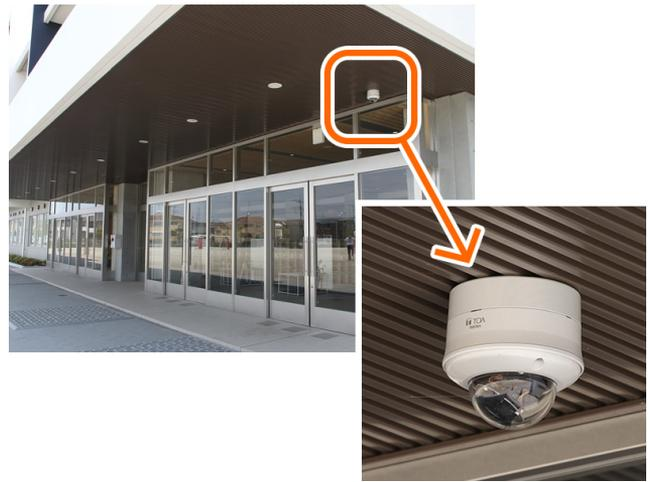
小学校校舎に設置された屋外フルHDネットワークカメラN-C5420-3（左）と、中学校校舎に設置された屋外ドーム赤外フルHDネットワークカメラN-C5850R3（右）。人の出入りなど、広い敷地全体を死角なく確認できる。
