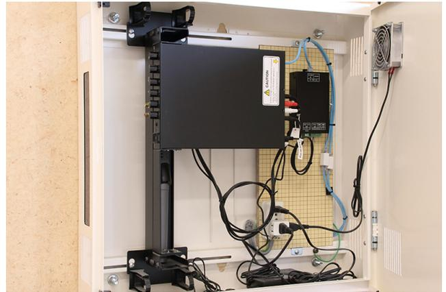
教室内拡声システムの赤外線チューナー。赤外線スピーカーとの接続はLANケーブル1本のみ。
