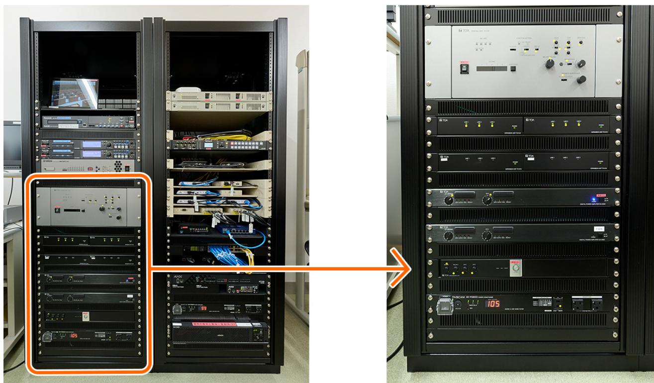
有線会議システムのセンター装置TS-910などが収納された機器収納架。
