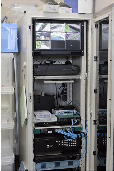
TRIFORAシステムのラック設備。ラック内にもモニターを設置して河川監視カメラの映像が確認できる。
