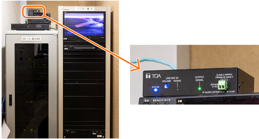
事務所に設置されたIP音声インターフェースIP-A1AF。 Wi-Fi経由でBGM音源をアナログ変換して各フロアに流している。
