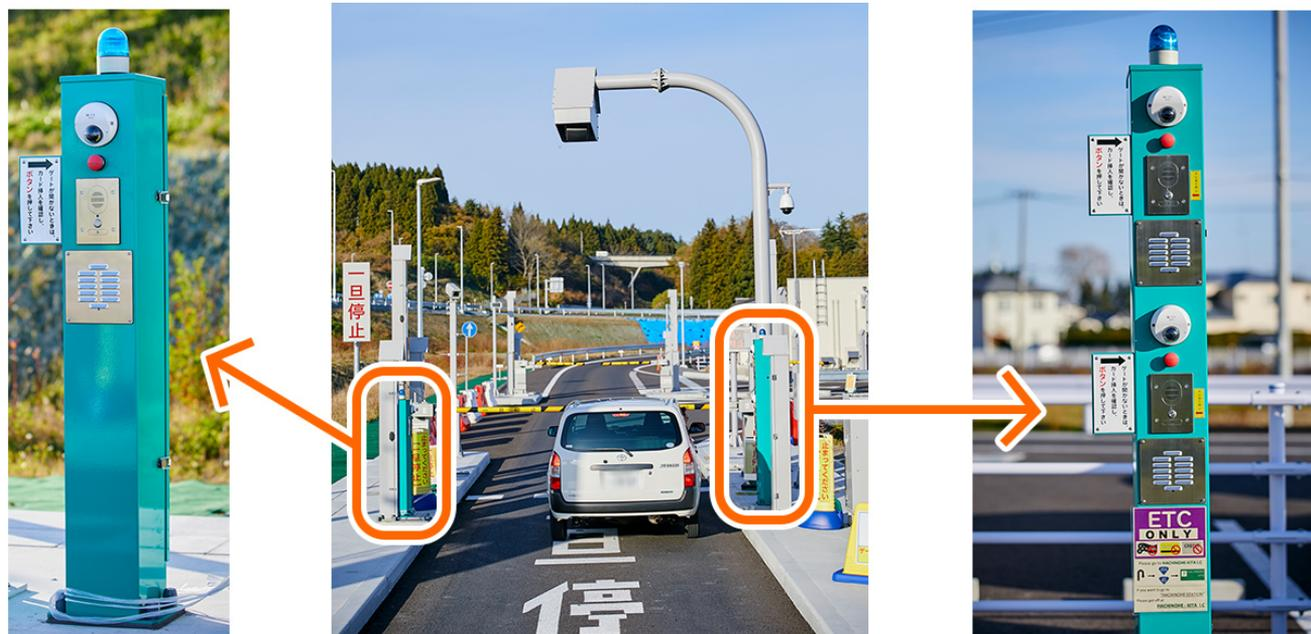
八戸西スマートICの上り線入口レーンにある通信開始装置。右側にはトラックなどの大型車両用（上）と、普通車用（下）として2カ所に屋外ミニドームフルHDネットワークカメラとIPインカムドア端末が設置されている。左側は、左ハンドル車用。
