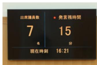
本会議場の側面に設置されている70型の大型モニター。マイクと連動して映し出される発言者の映像や、出席議員者数と発言残時間、電子採決の結果などをソフトウェアのボタンひとつで切り換えて表示できる。
