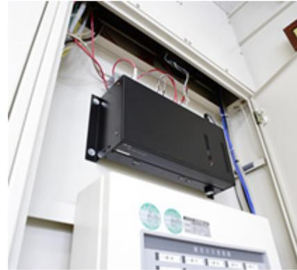
職員室にある非常用放送設備に接続されたパケットインターカムシステムのマルチインターフェースユニットN-8000MI。教室の非常用ボタンが押されると校内放送設備と連動して緊急通報メッセージが放送されます。
