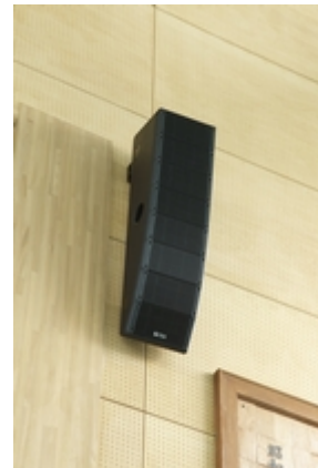
体育館に設置された防球仕様のラインアレイスピーカー SR-T5 。反響・残響を抑え、明瞭性に優れています。竣工記念式典でのお披露目の際にも、非常に高い評価をいただいています。
