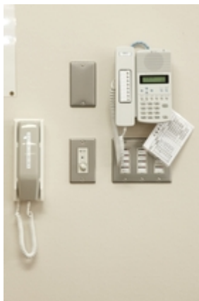
職員室に設置されたIP多機能マスター端末 N-8500MS 。 液晶画面搭載で、通話先が表示されます。各教室端末の番号表が掛けられています。
