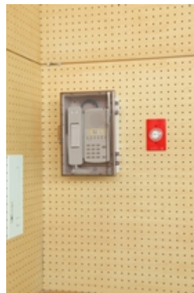
体育館に設置されたIP標準マスター端末 N-8510MS 。 バスケットボールなどが当たっても大丈夫なように、堅牢なケースの中に設置されています。
