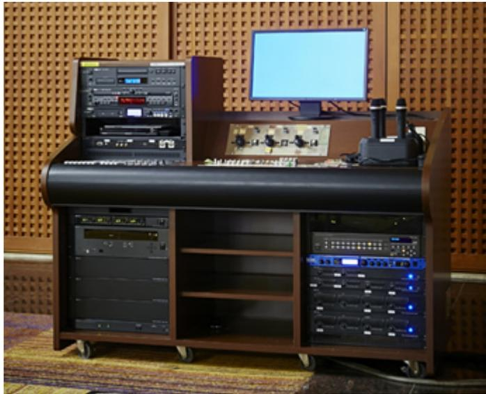
梅の間に置かれたメインの音響映像システム、左上には、デジタルミキサーD-2000シリーズと演奏機器、下部にはデジタルワイヤレスチューナーWT-D1804、右下にはデジタルパワーアンプDA-550F/250D/250Fなどが収納されている。
