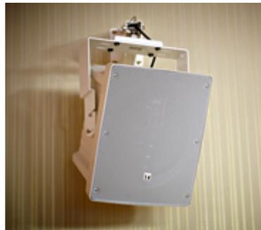
各パーティション区分の四隅に設置されているコアキシャルアレイスピーカーHS-1200WT、ホール全体を通して使用する場合はメインスピーカーを補助するサブスピーカーとして、各パーティション区分で利用される場合は、メインスピーカーとして明瞭性の高い音を届ける。
