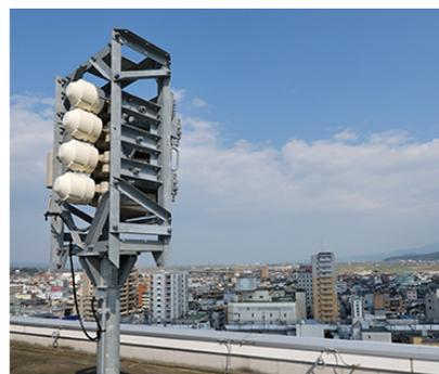
諫早市役所の屋上に設置された防災行政無線システムの屋外拡声装置(長距離型スピーカー)。屋上の4角より市街地に向けて放送される。
