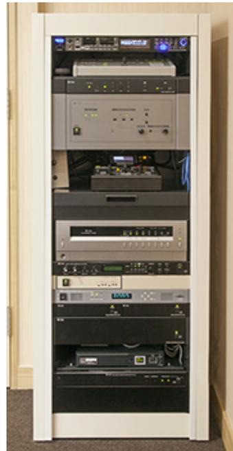
操作席横にある、議場用システムの制御機器ラック。センター装置TS-800やデジタルプロセッサDP-M3などを収納。
