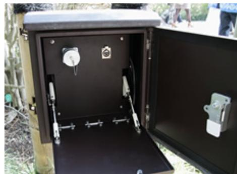
料金所内に設置されたリモートマイク（上）と、園内3カ所に設置されたリモートマイク接続盤（下）。リモートマイクを接続して非常時やイベント時の案内放送を行うことができる。
