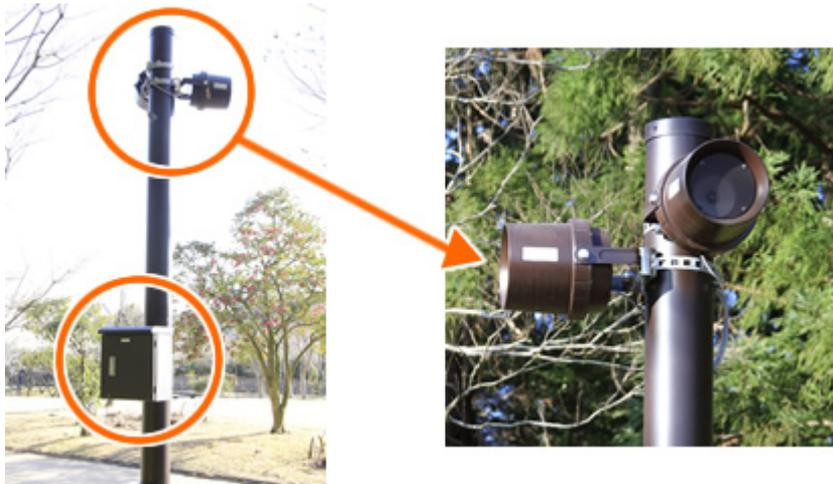
向学立志の像付近に設置されているワイドホーンスピーカー。こちらも景観に配慮して、特別色で対応。ポールの下にはリモートマイク接続盤が取り付けられ、非常時にはリモートマイクを接続して放送が可能。
