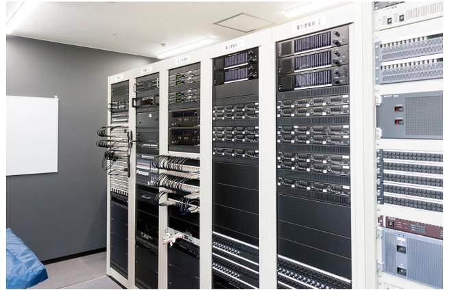
出力制御架、電力増幅架、音響架。デジタルミキシングプロセッサユニットの他に、デジタルパワーアンプ、周囲の騒音に合わせてアナウンス音量を適切に調整するデジタルアンビエントノイズコントローラーDP-L2などが収められている。
