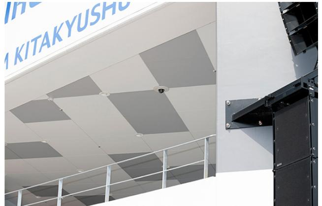
リアルタイムの防犯監視や、映像記録による事件や事故の際の追跡・確認を目的に、耐塩塗装が施された屋外ドーム型フルHDネットワークカメラN-C3820-3などがスタジアム内に設置されている。
