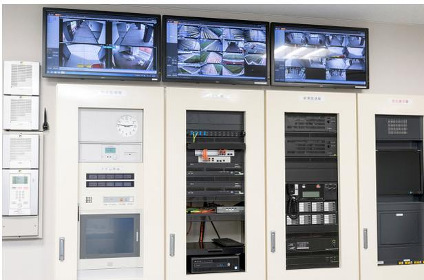
管理事務室内にあるITV架と非常放送架。3台のモニターでスタジアム内のネットワークカメラの映像を表示している。
