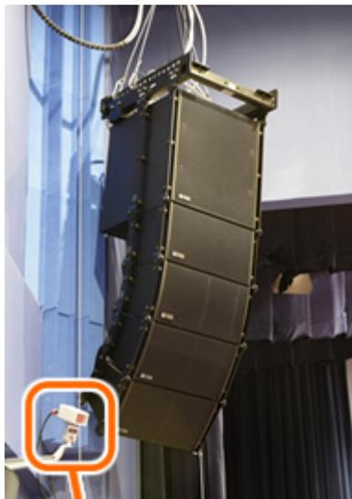
ホール前方の左右にはメインスピーカーとしてラインアレイスピーカーtypeCを配置。遠距離用のSR-C8Lと近距離用のSR-C8S、サブウーハーSR-C15Bの組み合わせで、用途を選ばず、高音質で明瞭性の高い音をホールに届けることが可能。
