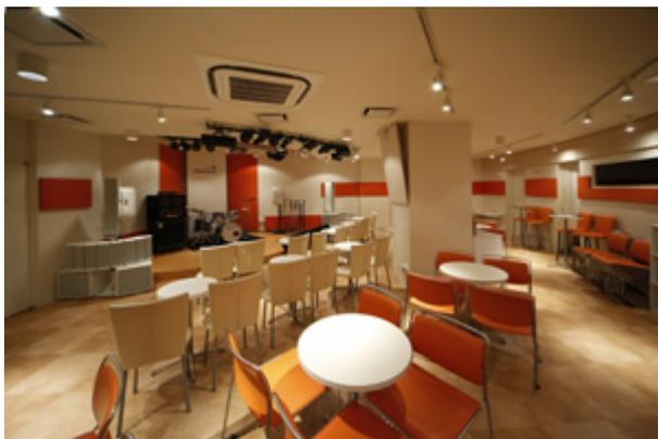
白を基調にした音楽室DXの室内全景。ステージを中心として扇状に広がったレイアウトを、センターに設置しているtypeH、左右に設置しているtypeS、コンパクトアレイスピーカー2連、下段のサブウーハーでカバー。
