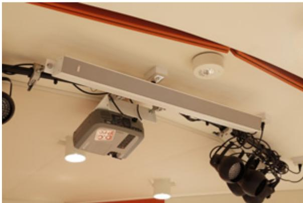
ステージ天井のセンターに設置されているスリムな SR-H3L (typeH)。
