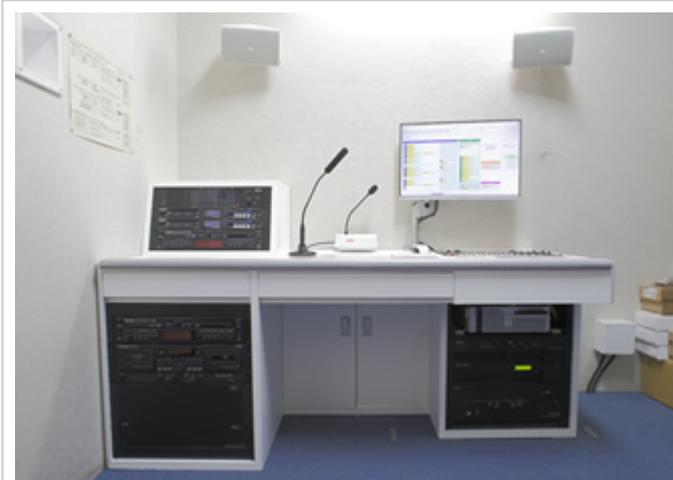
業務用放送設備の操作卓。さまざまな演奏機器は卓の左側に集約、右側には放送したいエリアや音量調整などの設定にも対応できる機器を配置。
