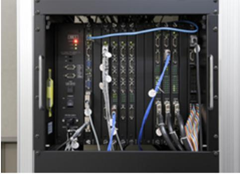
デジタルアナウンスマシンを制御して自動的に定時放送を行うアドレスセクター。
