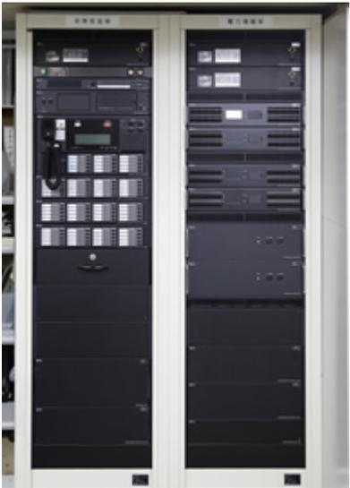
2013年9月に老朽化のために更新した非常放送設備。1階防災センターに設置されている。
