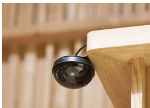
赤外線会議システムの送受光器TS-905が2台と、高天井用送受光器TS-907が3台で、20台のマイクユニットをカバーしている。
