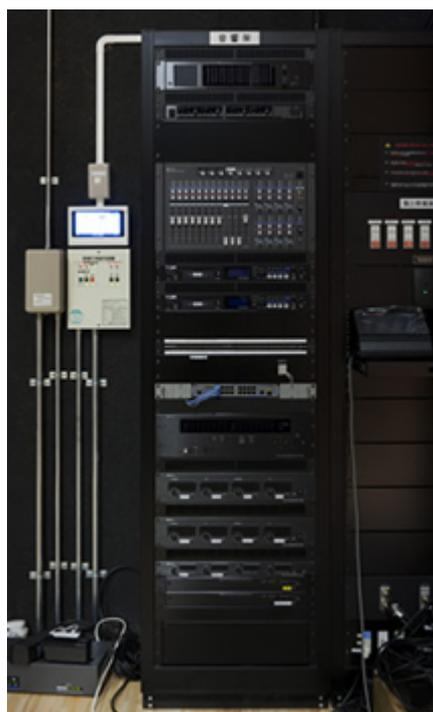
ホール音響システムの収納架。デジタルミキサーD-2000シリーズ、デジタルワイヤレスチューナーWT-D1804、デジタルパワーアンプDA-550Fなどが収められている。
