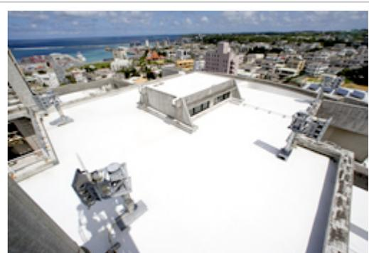
屋上には全部で5基のホーンアレイスピーカーを設置し、周辺に向けて放送を行っている。半径約800mのエリアはホーンアレイスピーカーの放送でカバーしている。
