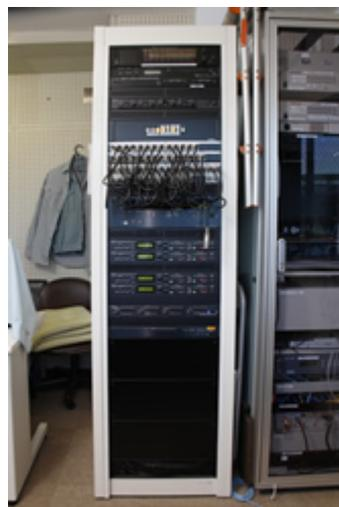
放送席・記録室にある効果調整架。デジタルミキシングプロセッサユニットのほか、デジタルアンビエントノイズコントローラー、デジタルパワーアンプなどを収めている。
