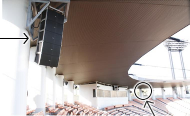
バックネット裏にある、メインスピーカーのラインアレイスピーカー<typeA>。1塁側、3塁側にそれぞれ2基ずつ設置されている。
