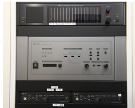
議場制御架の赤外線会議システムのセンター装置 TS-900,
