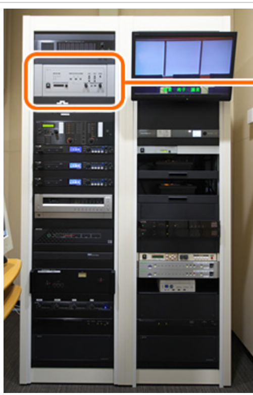
議場制御架の赤外線会議システムのセンター装置 TS-900,
