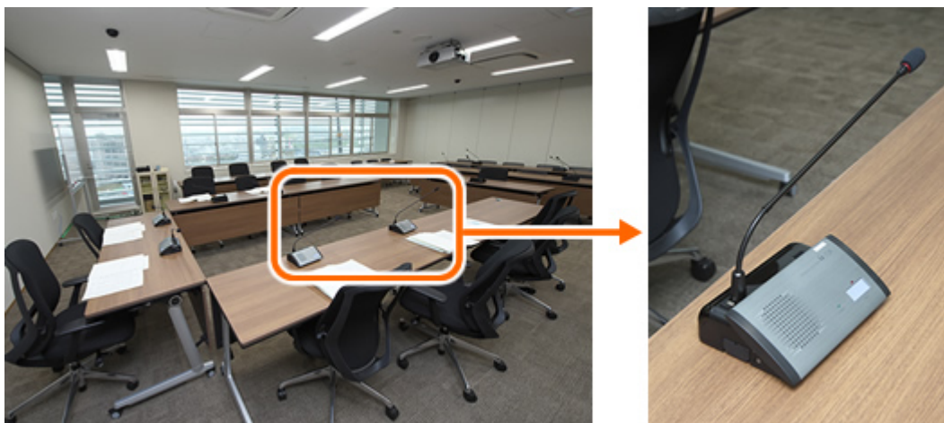
委員会室のAV 設備には、赤外線会議システムTS-800シリーズを採用。委員会の参加者数、席レイアウトにも左右されず、柔軟な対応が可能。
