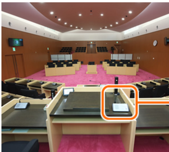
議長席に設置されている赤外線会議システムの議長ユニットTS-901。指向性の高いマイクとの組み合わせでハウリングも抑制。
