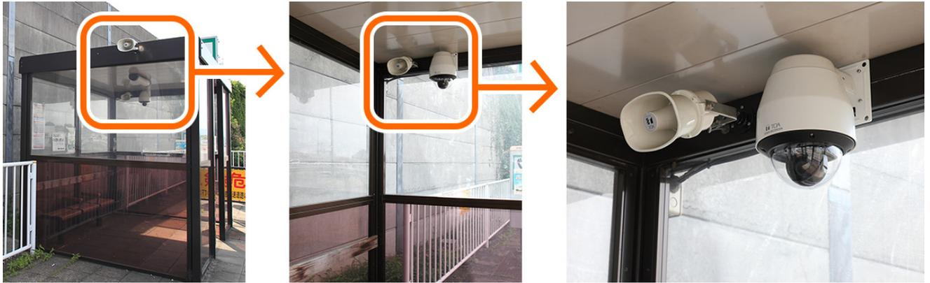
カメラ・レコーダー・デジタルアンプ一体型で、LTE通信(無線)により待合室の限られた空間でも省スペースで設置することができる。既設のAC電源の利用で、専用ネットワークなどの通信インフラ設置が必要なく、施工も短期間で終わることができた。
