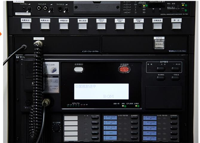
災害に対する集中管理および津波等による水害対策のために、4階に設置された非常用放送設備の本体アンプ。以前は分散配置されていたガーデン棟用の非常用放送設備も集約されています。
