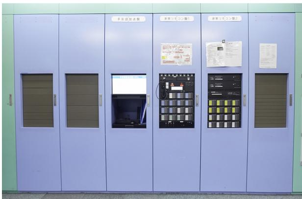
地下1階の防災センターに設置されたラック架。以前の非常用放送設備は、タワーイースト・ウエスト用のアンプ設備、非常リモコンだけでラック5本分を占有していました。今回の更新で多言語放送支援システムも含めて、ラック3本分と省スペース化でき、非常放送の操作もスピードアップできています。
