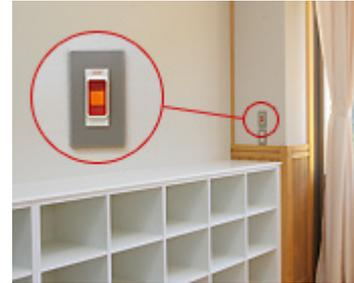
教室の前後に設置されている緊急通報ボタン。このボタンを押すと、IP端末、校内放送で緊急通報が可能。
