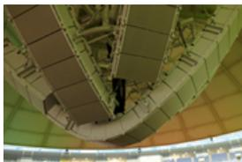
綿密な音響シミュレーションの結果、TOAが提案したのはセンタークラスターラインアレイスピーカーを核とした音響システムでした。合計76台のスピーカーユニットは、残響音の多い条件にあっても音声聞き取りやすく、カバーエリアのどの客席へもクリアで迫力のある音を耳に届けることで、「大歓声の中でも音声ダイレクトに聞こえて心地よい」とのご感想をいただいています。
