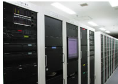
フライトインフォメーションシステムの自動放送装置
