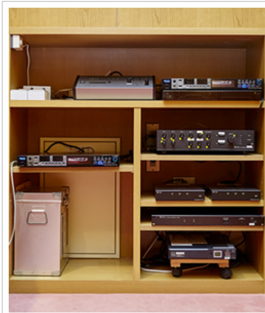
操作席の右後方の棚には、議場用システムの制御機器が収められている。
