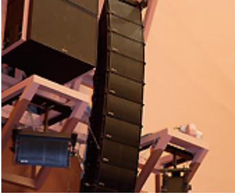
ステージ両脇の壁面に設置されたラインアレイスピーカーtypeC。複数のスピーカーをタテに並べて配置し、遠方まで明瞭性の高い音を伝える。
