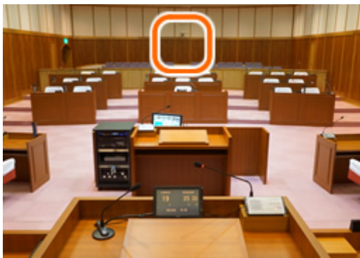
傍聴席後方にある議長席、演壇席、執行部席撮影用のHDカメラ、議員席撮影用に、本会議場前方に2台のHDカメラが設置されている。
