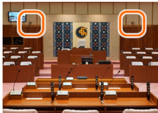
傍聴席後方にある議長席、演壇席、執行部席撮影用のHDカメラ、議員席撮影用に、本会議場前方に2台のHDカメラが設置されている。
