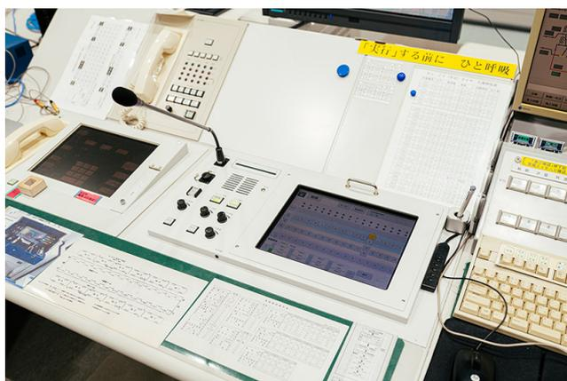
中央指令所から各駅へのマイク放送、定型放送を行う運転指令放送操作盤。各駅の放送先選択や放送言語の選択、放送機器の状態表示をタッチパネル操作で行うことができる。
