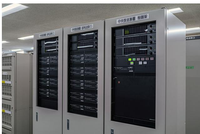
中央指令所から各駅への放送を行う中央放送装置の制御架（右）と音声伝送架（中央・左）。
